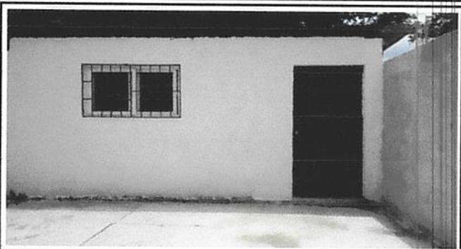
Foto 2: Reparación de ventana para cocina pvc 1.00x1.00 mts con cedazo y sustitución de puerta de metal
